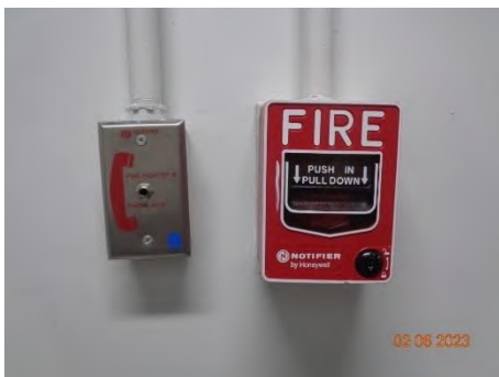
ภาพที่ 2.2-41 อุปกรณ์แจ้งเหตุด้วยมือ (Manual Pull Station)
