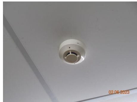
ภาพที่ 2.2-28 เครื่องตรวจจับควัน (Smoke Detector)
