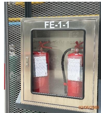
ภาพที่ 2.2-46 TAG ตรวจสอบถังดับเพลิง
