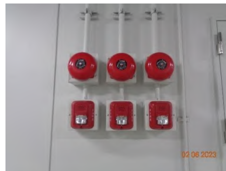
ภาพที่ 2.2-42 ลำโพงแจ้งเหตุเพลิงไหม้ (Alarm Speaker)
