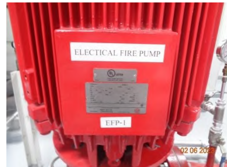
ภาพที่ 2.2-33 เครื่องสูบน้ำดับเพลิงแบบไฟฟ้า
